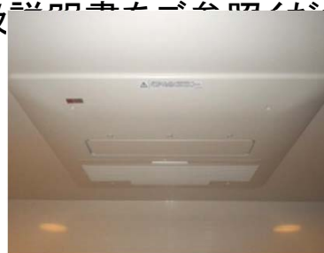
浴室暖房乾燥機
